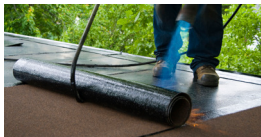
Pose de revêtements de toiture
